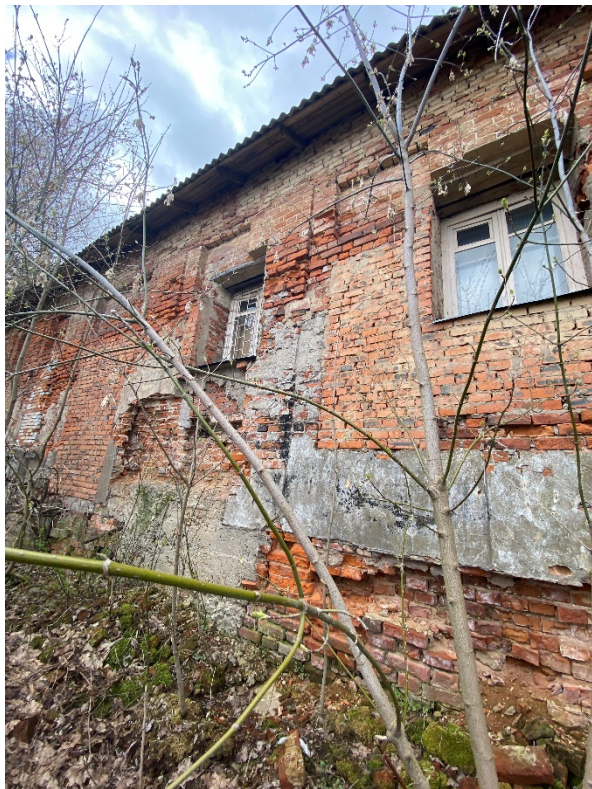
Фото 5. Фрагмент северо-восточного фасада.
