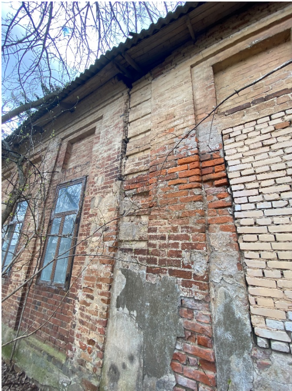
Фото 11. Фрагмент северо-восточного фасада. Граница двух строительных периодов. Справа рустом ограничивается объем 1786 года, слева пристройка кон. XVIII в.
