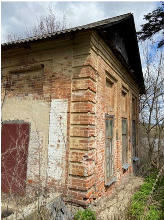
Фото 13. Юго-восточный фасад. Кладка стены в хорошем состоянии. Все элементы декора в сохранности: лопатки, ниши, венчающий карниз, угловой руст.
