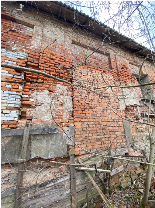
Фото 7. Фрагмент северо-восточного фасада.
