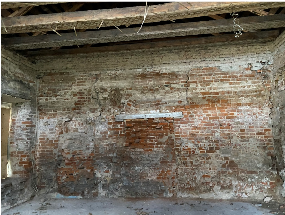
Фото 20. Западная пристройка. Капитальная стена с заложенными проемами.
