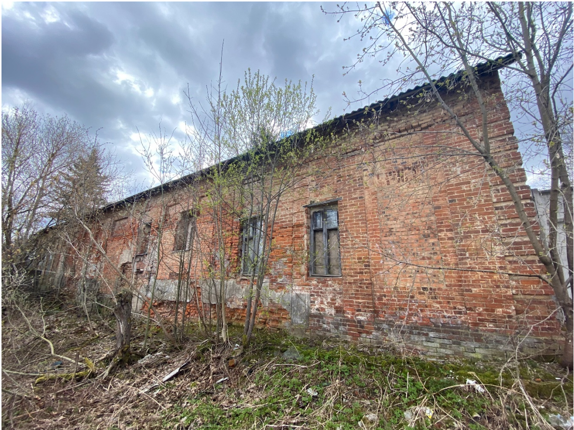
Фото 4. Фрагмент северо-восточного фасада.
