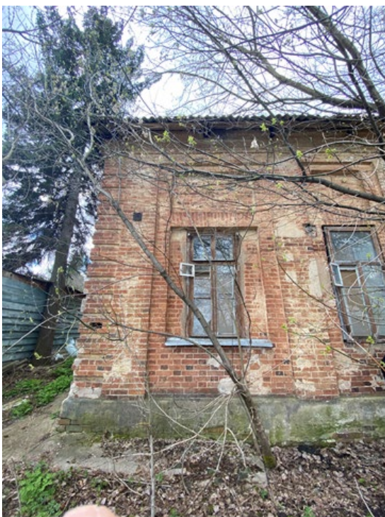
Фото 12. Фрагмент северо-восточного фасада. Кладка стены в хорошем состоянии. Все элементы декора в сохранности.
