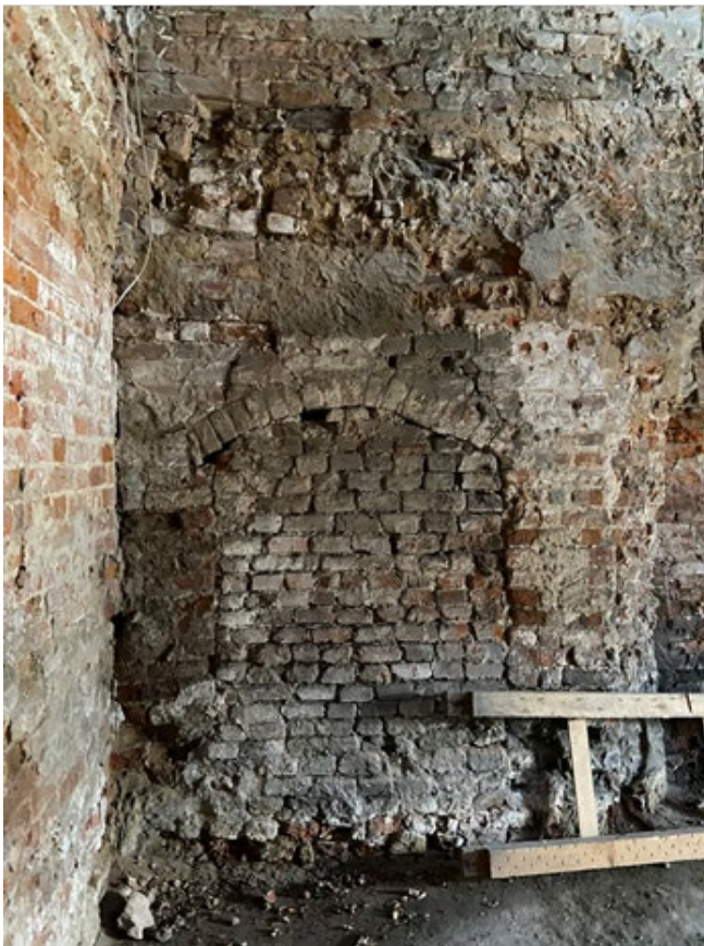
Фото 22. Западная пристройка. Фрагмент наружной стены со следами перекладок, срубленного кирпича.
