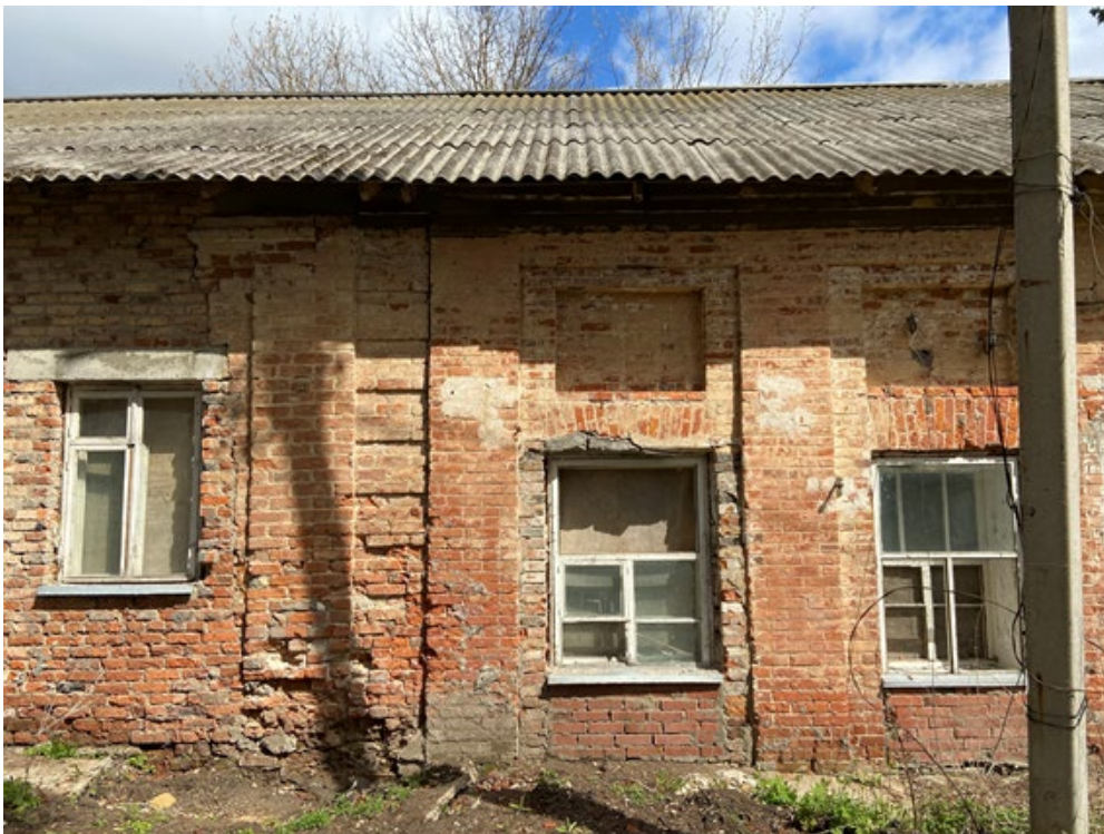
Фото 16. Фрагмент юго-западного фасада. Рустом выделено место стыка двух исторических периодов. Справа пристройка конца XVIII в., в левой части сохранилась лопатка и руст 1786 года. Левее после лопатки расположена кладка стены 1930-50 гг.
