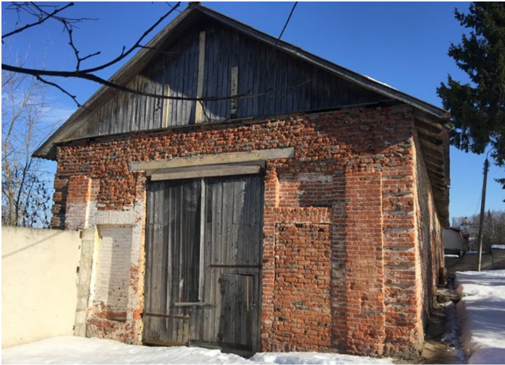
Фото 19. Северо-западный фасад. Сохранившаяся часть кладки стены находится в хорошем состоянии. По центру фасада прорублен широкий проем с бетонной перемычкой и деревянными воротами.
