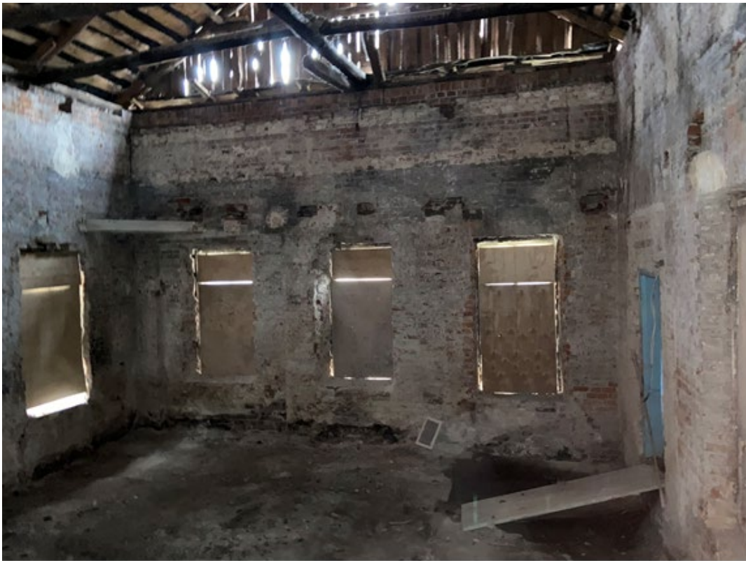
Фото 23. Восточная пристройка. Наружная стена с оконными проемами.
