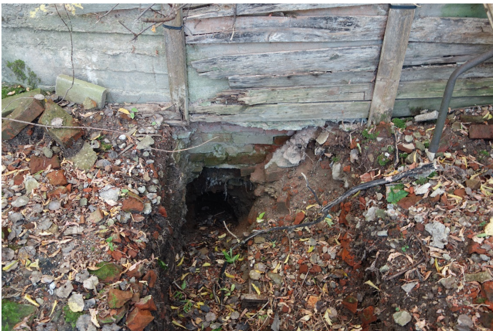
Фото 8. Фрагмент северо-восточного фасада.
