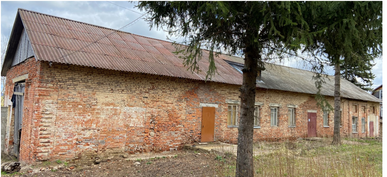
Фото 2. Юго-западный фасад со стороны двора. Общий вид.
