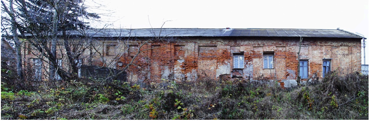
Фото 1. Северо-восточный фасад со стороны реки. Общий вид.
