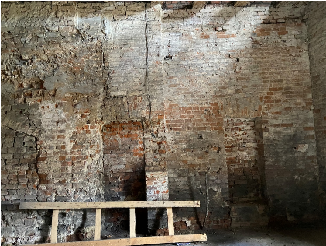
Фото 21. Западная пристройка. Наружная стена.
