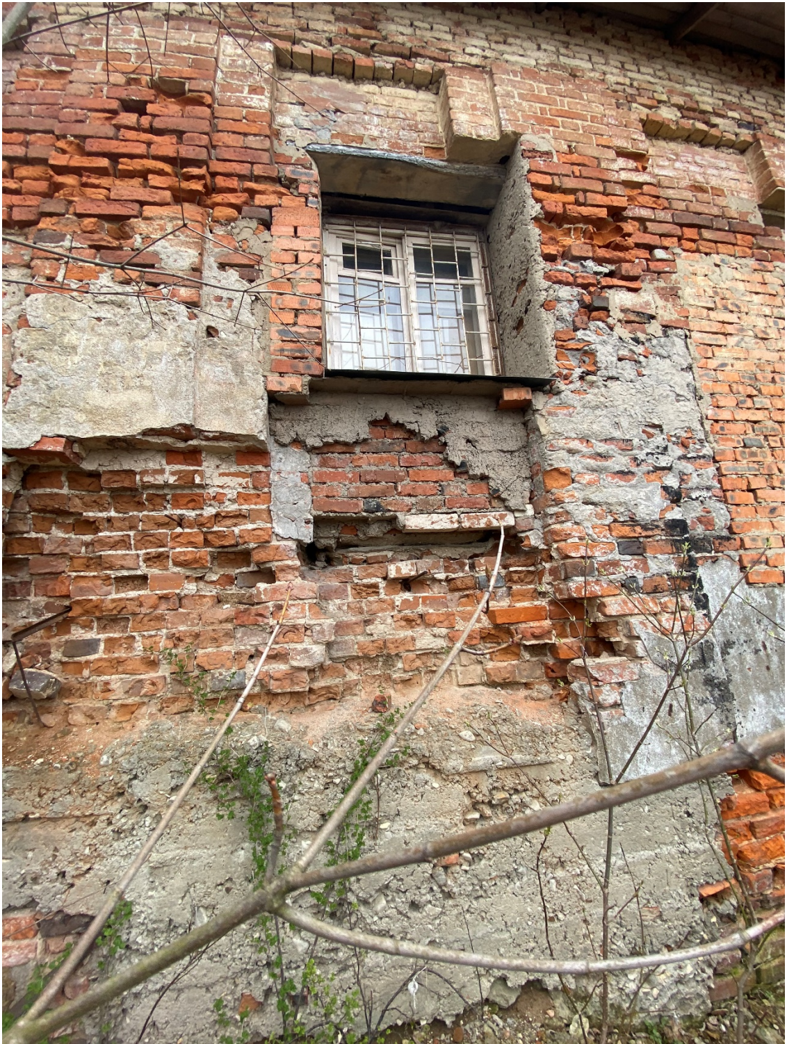
Фото 6. Фрагмент северо-восточного фасада.
