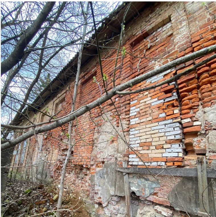
Фото 10. Фрагмент северо-восточного фасада.
