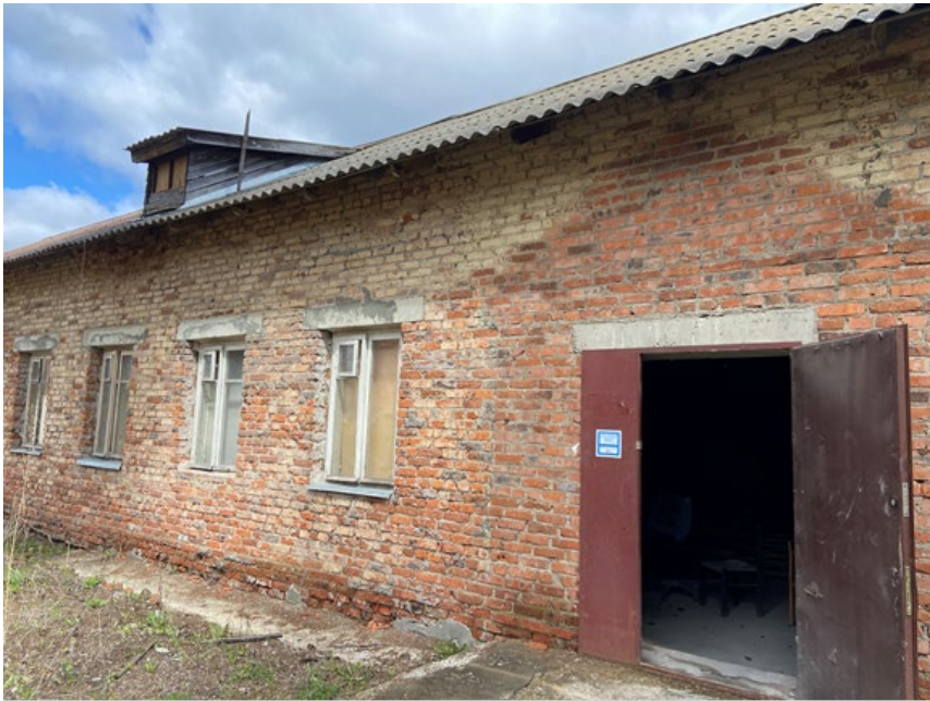
Фото 17. Фрагмент юго-западного фасада. Кладка стены 1930-50 гг. Бет
